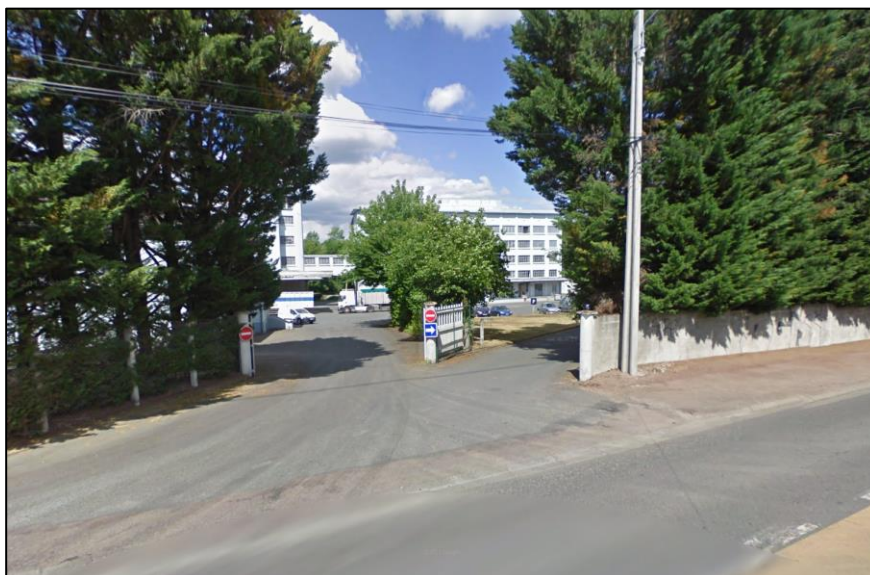
Portail – Entrée du site
